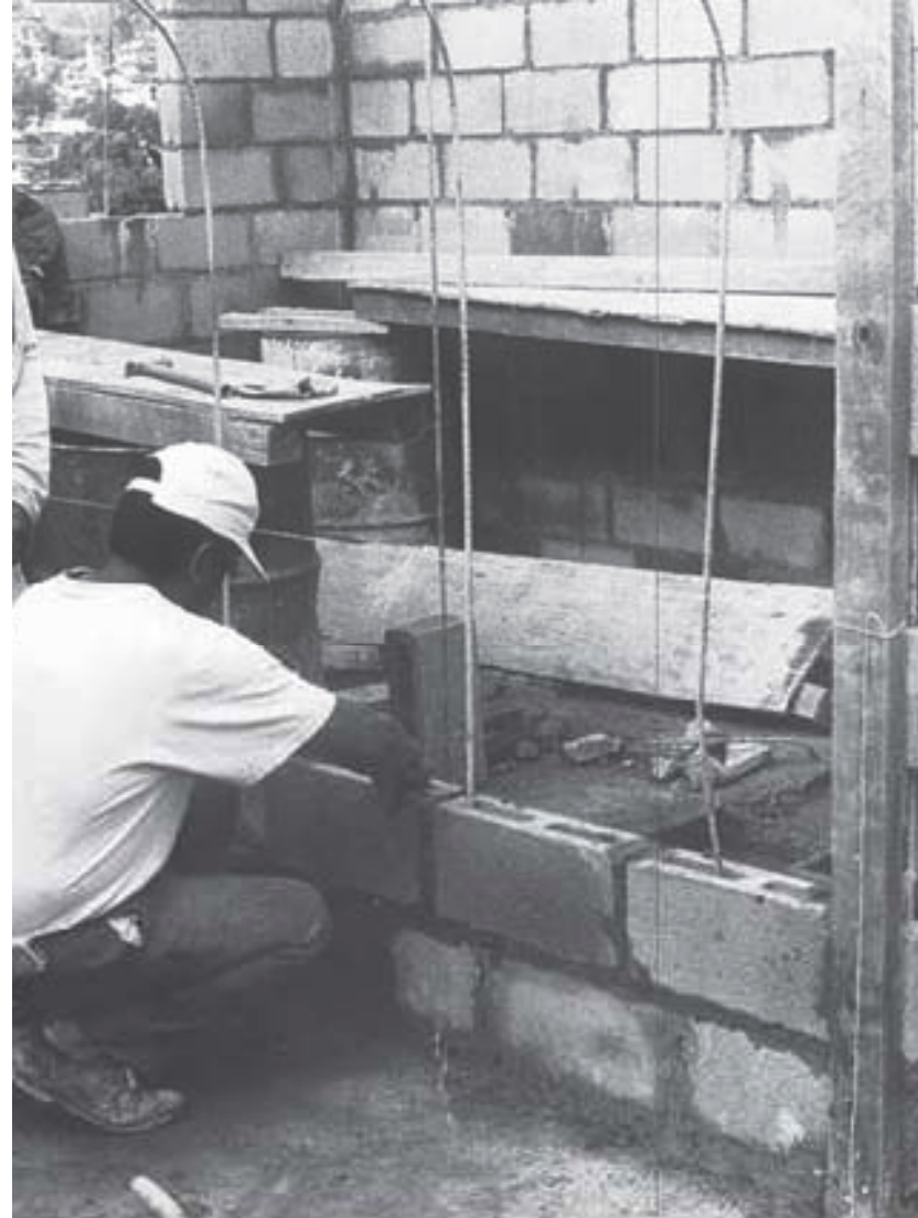
Foto 13 Junteado y pegado de block hueco de cemento.
