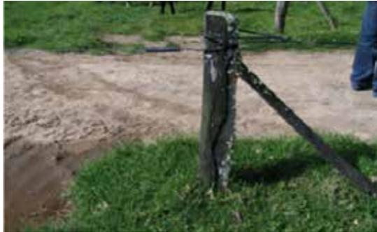
Posteriormente se colocan los postes intermedios cada 8-10 metros y se sujeta el alambre con aisladores.
